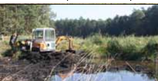
Oberbodenabtrag, Moor in BB
